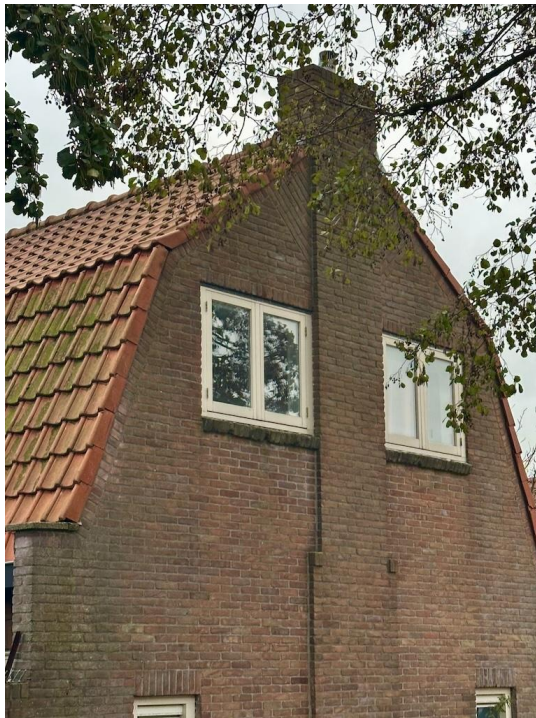
Een mansardedak (ook wel gebroken dak genoemd), is een zadeldak met geknikte dakvlakken. Foto: Michiel Huijsman
